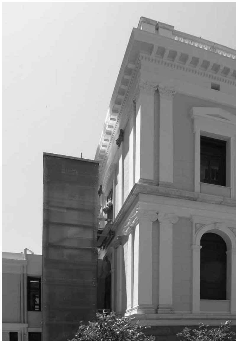
Ιλίου Μέλαθρον. Ανεγκυστήρας ΑμεΑ
