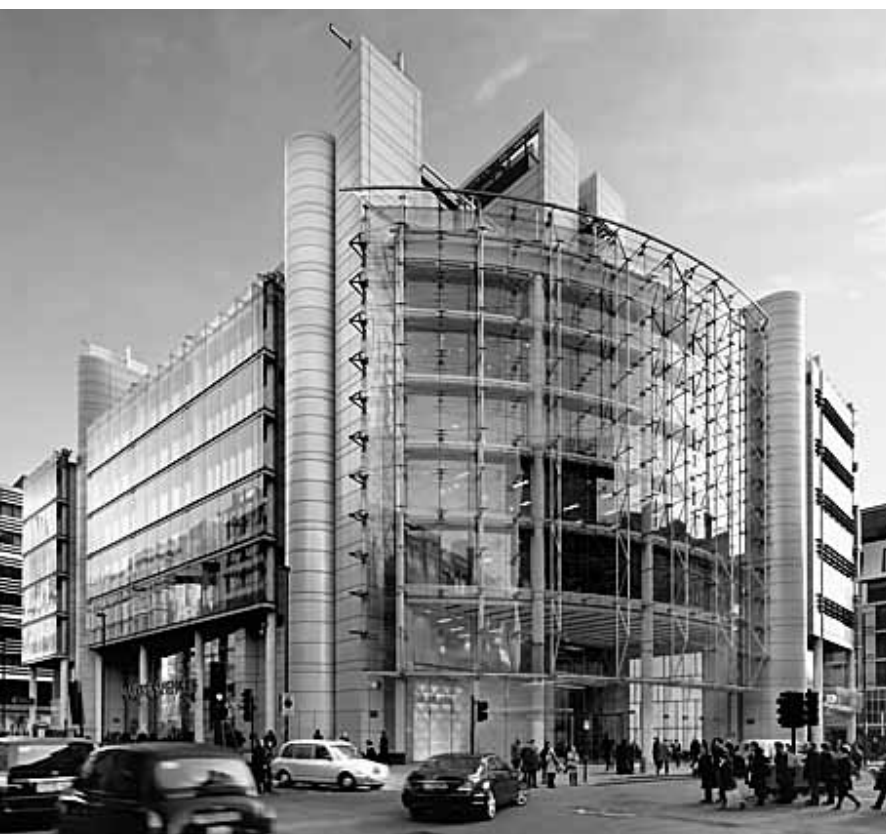
Εικ. 2: Κτήριο γραφείων Helicon στο Λονδίνο. Αρχιτεκτονική μελέτη: Sheppard Robson, πηγή: www.sheppardrobson.com
