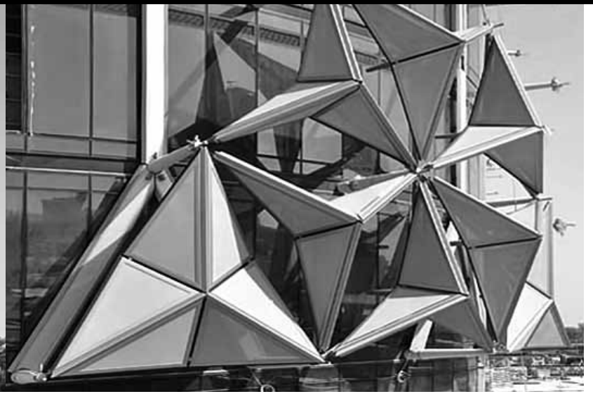
Εικ. 3α και 3β: Πύργοι Al Bahh στο Άμπου Ντάμπι. Γενική άποψη και λεπτομέρεια ηλιοπροστατευτικού συστήματος. Αρχιτεκτονική μελέτη: Aedas Architects Ltd πηγή: www.aedas.com
