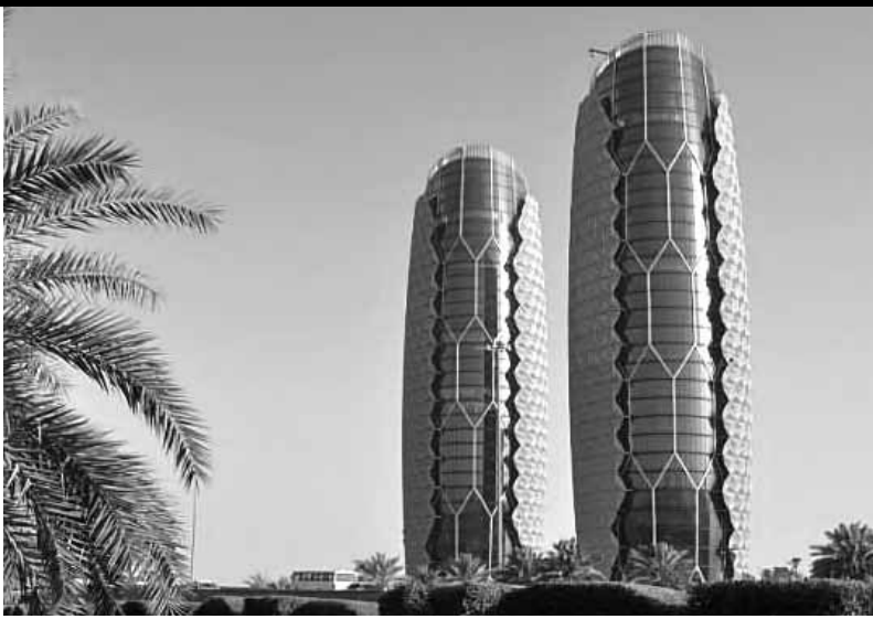
Εικ. 3α και 3β: Πύργοι Al Bahh στο Άμπου Ντάμπι. Γενική άποψη και λεπτομέρεια ηλιοπροστατευτικού συστήματος. Αρχιτεκτονική μελέτη: Aedas Architects Ltd πηγή: www.aedas.com
