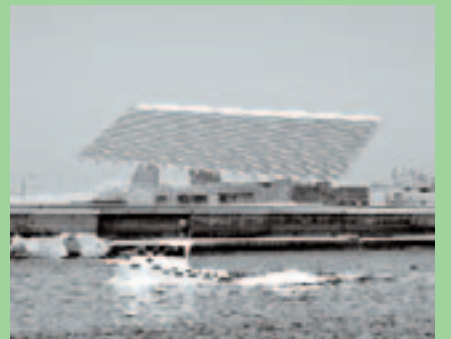
Φωτοβολταϊκό πάνελ στη Βαρκελώνη, Ισπανία
